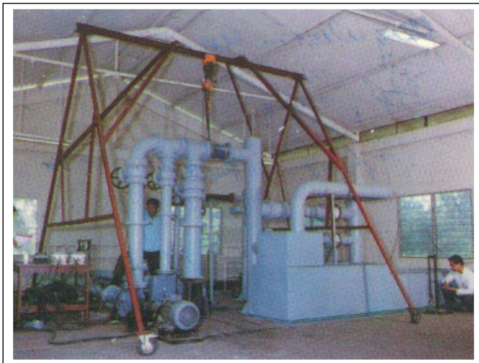
Lampiran 2. Instalasi pengujian pompa di BBP Mektan, Serpong
